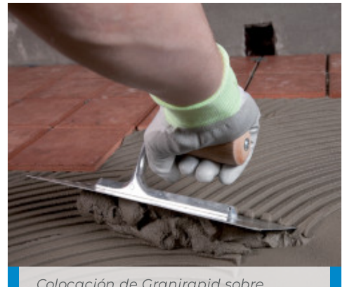
Colocación de Granirapid sobre terraza impermeabilizada con Mapelastic
