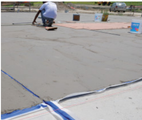
Impermeabilización de los recrecidos con Mapelastic y Mapeband
