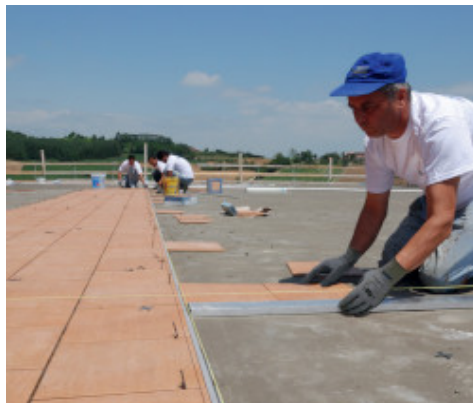
Colocación de cerámica con Kerabond + Isolastic
