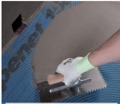
Aplicación de Mapelastic sobre Mapenet 150
