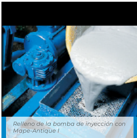
Amasado de mortero de inyección Mape-Antique I
