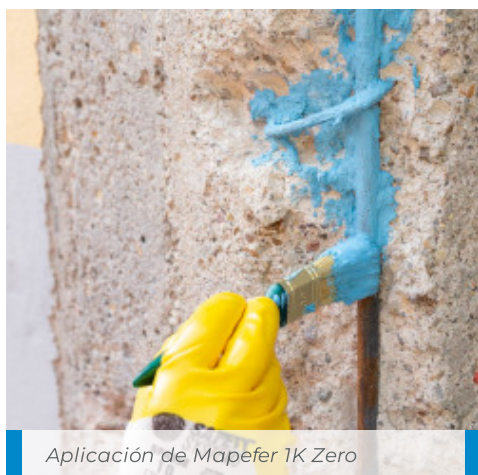
Aplicación de Mapefer 1K Zero sobre las armaduras en un viaducto
