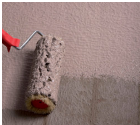
Impermeabilización a rodillo
