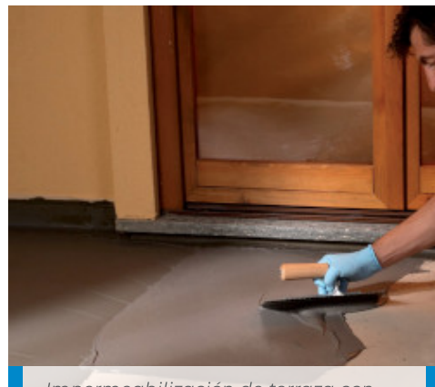
Impermeabilización de terraza con llana
