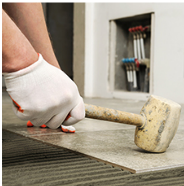
Con un mazo de hule golpee ligeramente las piezas para nivelar y sacar el aire atrapado.
