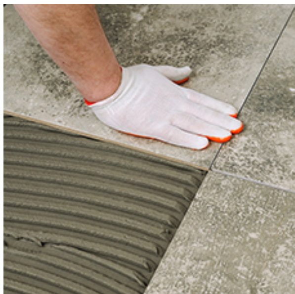
Coloque las piezas sobre el adhesivo presionando mientras mueva la pieza en sentido perpendicular al adhesivo
