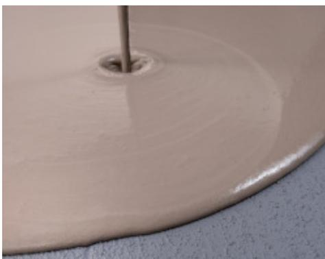
Aplicación de enlucido autonivelante sobre Eco Prim Grip Plus seco y aplicado sobre viejo pavimento
