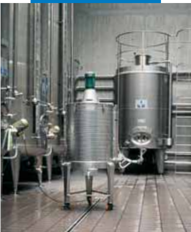
Ejemplo de rejuntado en una empresa vinícola
