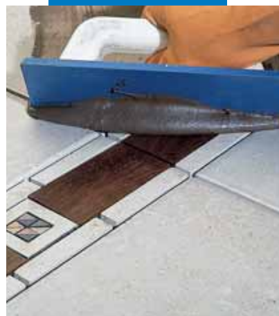
Rejuntado de pavimento cerámico con inserciones de madera, con llana
