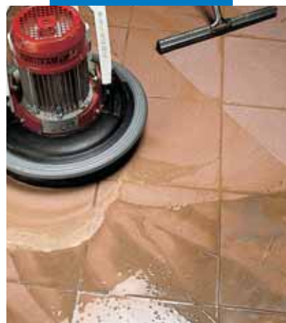
Acabado de pavimento porcelánico con máquina monodisco y regleta de goma
