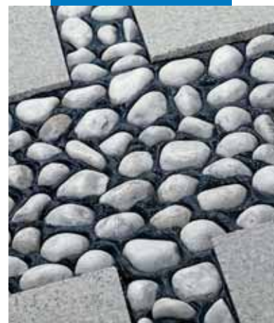
Ejemplo de rejuntado de piedras ornamentales
