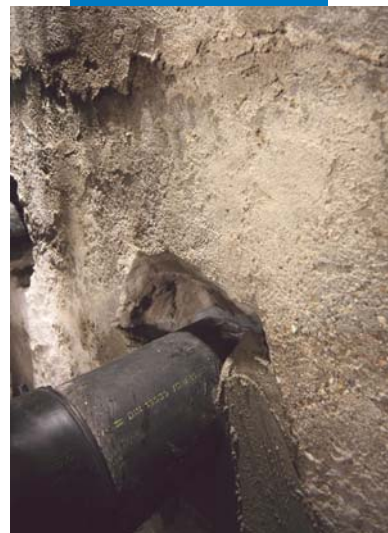
Confinamiento de Mapeproof Swell con Mapegrout T40
