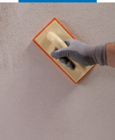
Acabado con fratás de esponja de Mape-Antique FC Grosso
