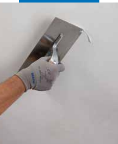
Detalle de la fase de aplicación de Mape-Antique FC Ultrafine
