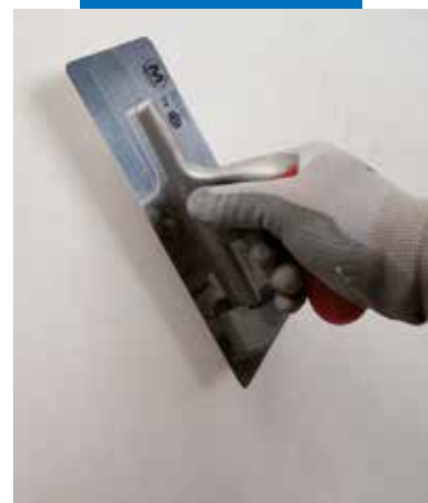
Aplicación de una segunda capa de Mape-Antique FC Ultrafine
