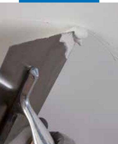
Alisado del producto con llana metálica lisa
