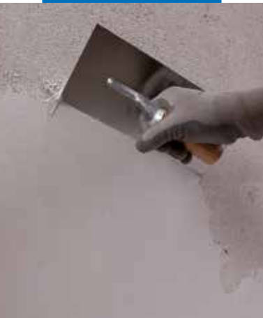
Aplicación de una primera capa de Mape-Antique FC Ultrafine
