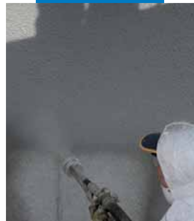
Ejemplo de aplicación por proyección de Mapelastic en un viaducto
