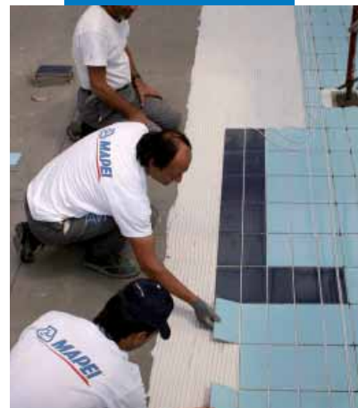
Colocación de revestimiento cerámico sobre Mapelastic
