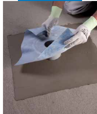
Colocación de Drain Vertical, cazoleta de sumidero sobre Mapelastic
