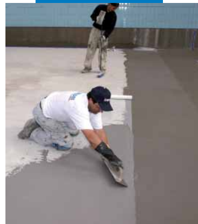
Impermeabilización de una piscina con Mapelastic
