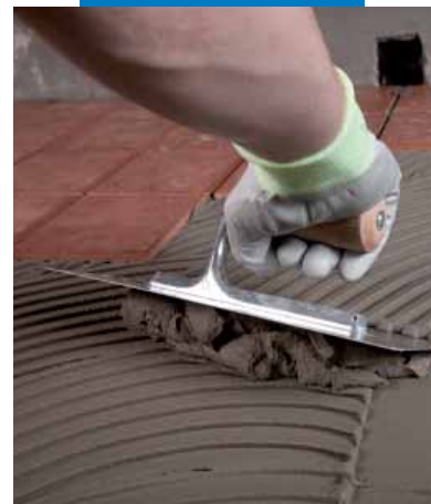
Colocación de Granirapid sobre terrazo impermeabilizado con Mapelastic
