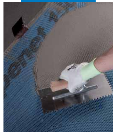
Aplicación de Mapelastic sobre Mapebet 150
