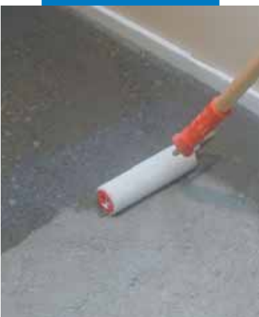
Aplicación de Primer G con rodillo
