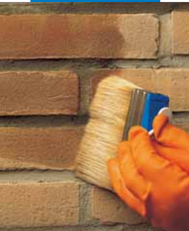
Aplicación a brocha de Antipluviol S
